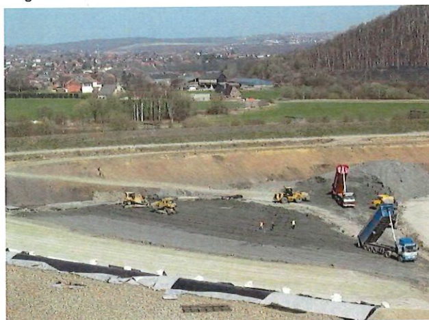
Mise en œuvre de l'étanchéité minérale constituée d'argile (= argile grise provenant d'un gisement yprésien) compactée et de bentonite
