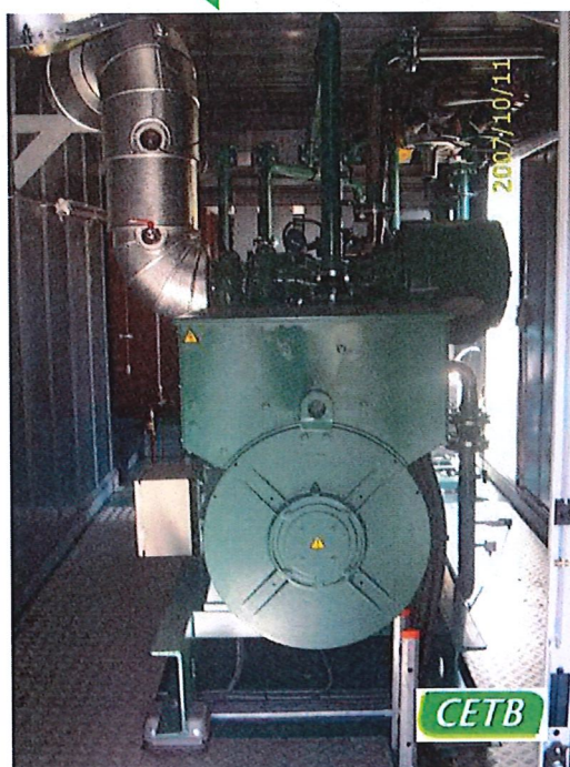
Le moteur à gaz de valorisation énergétique du biogaz
