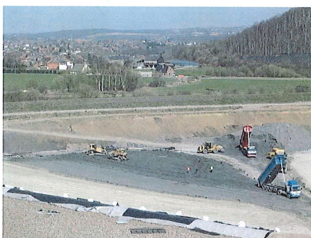
Mise en œuvre de l'étanchéité minérale constituée d'argile (= argile grise provenant d'un gisement yprésien) compactée et de bentonite
